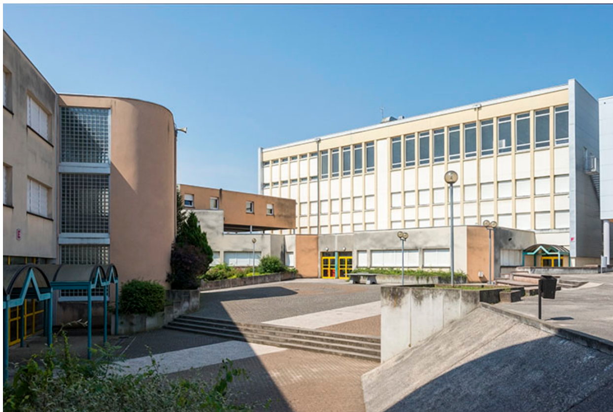
Partie sud de la cour.
