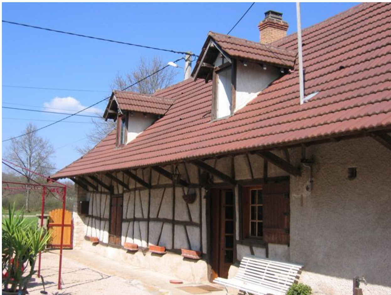
Vue d'ensemble de la façade.
