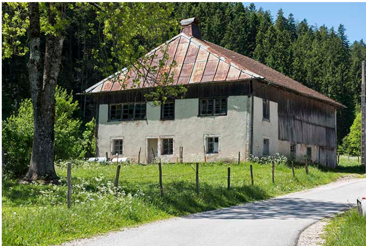
Façades nord et est.
