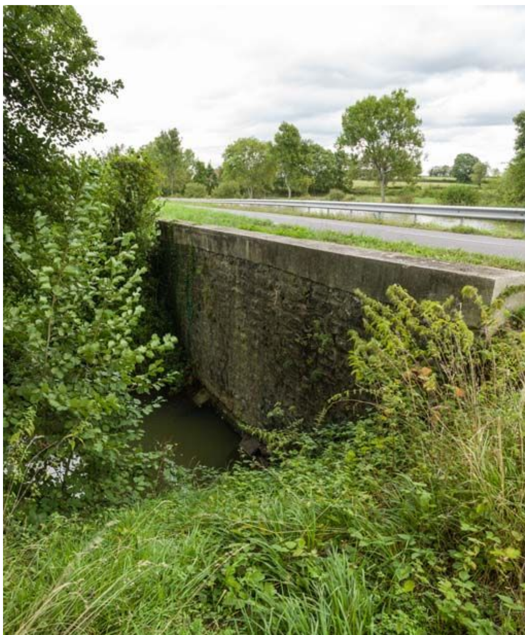
Vue de l'aqueduc.
