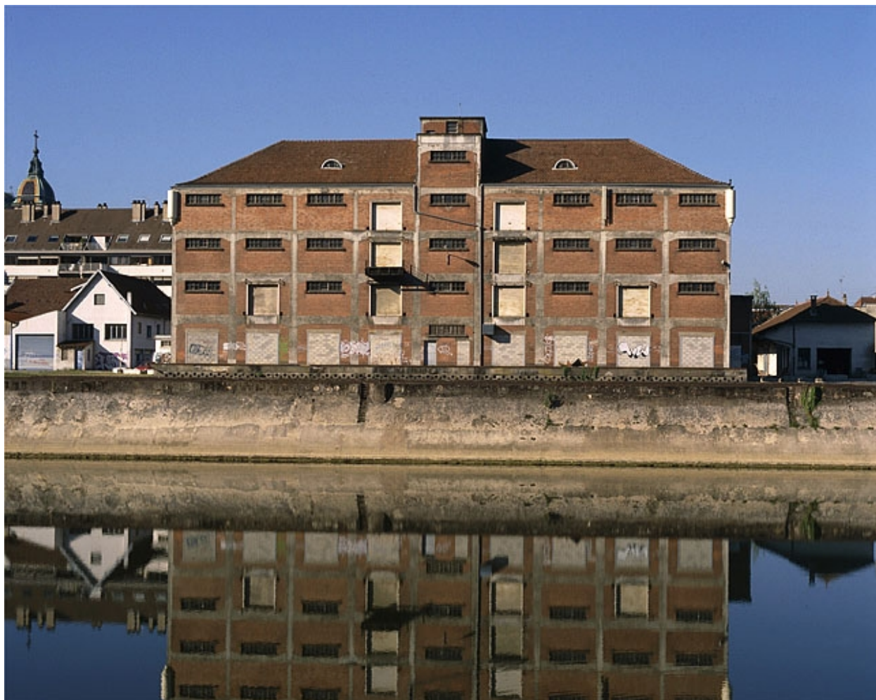
Entrepôt : façade postérieure (2003).
