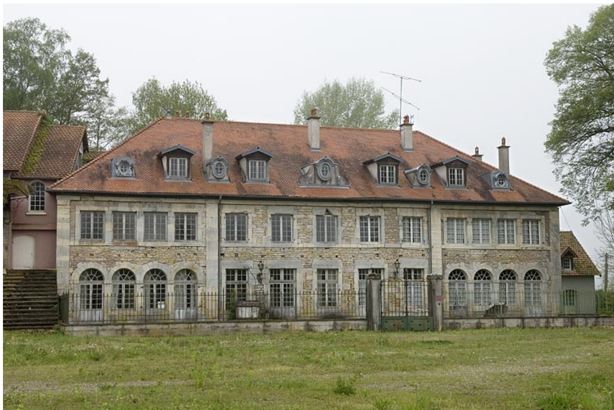
Logement patronal. Façade antérieure.
