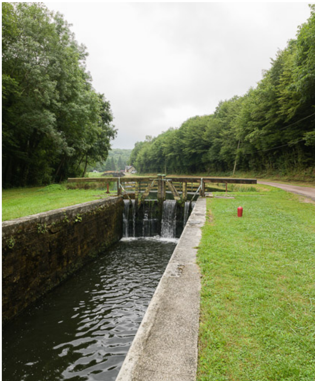
Vue du sas et du déversoir.
