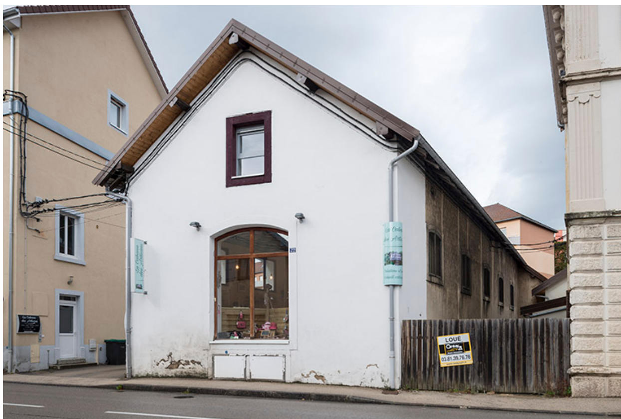
Pignon et façade nord.
