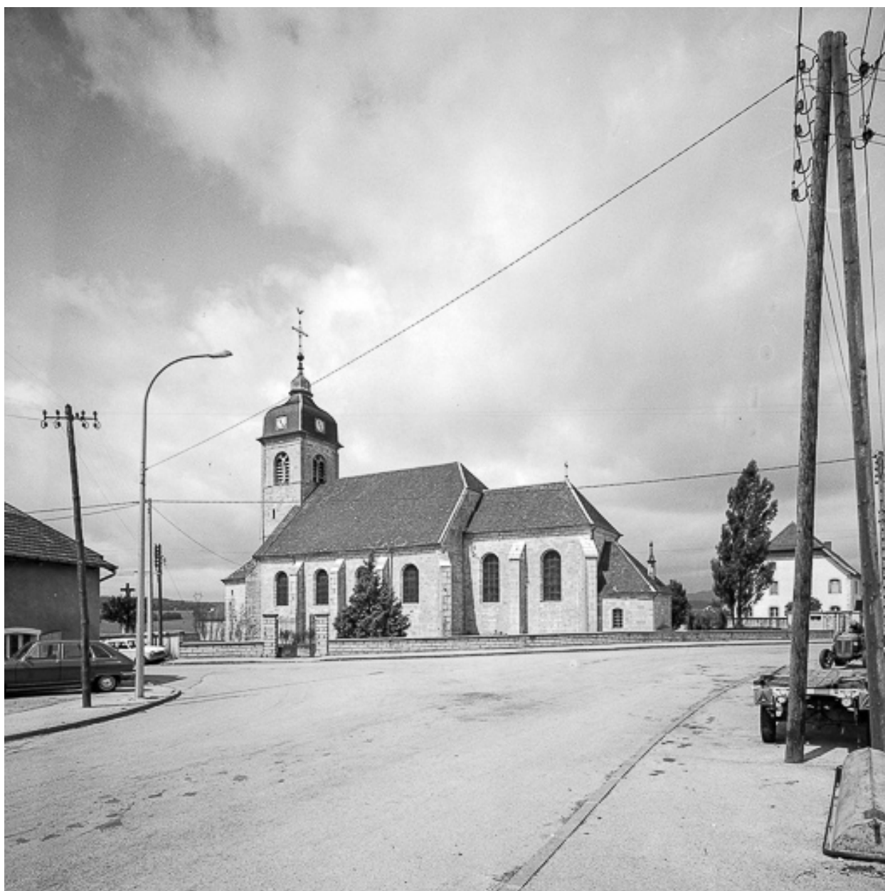
Façade latérale droite.
