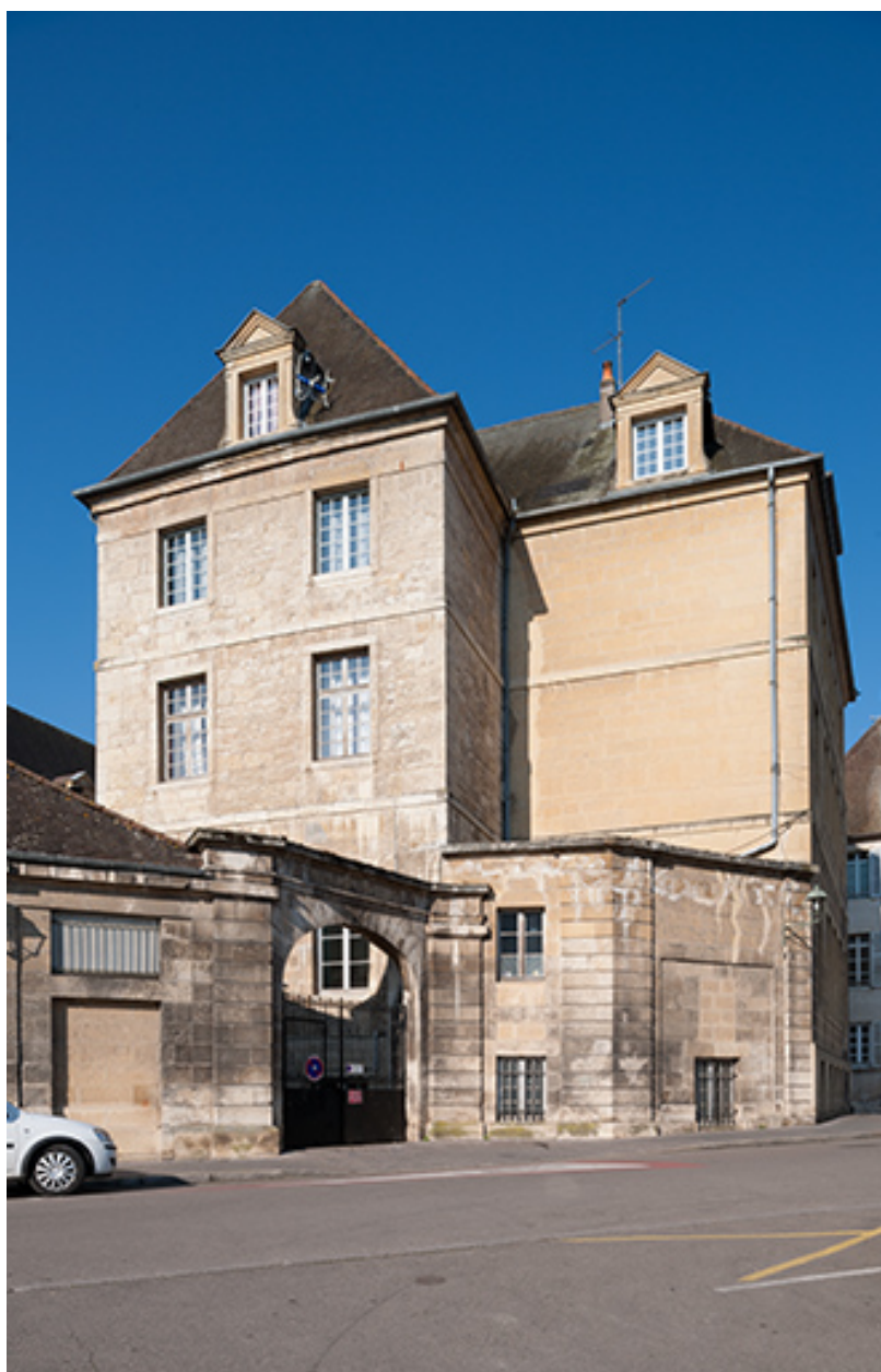
Façades des bâtiments d'externat, rue des Boucheries.
