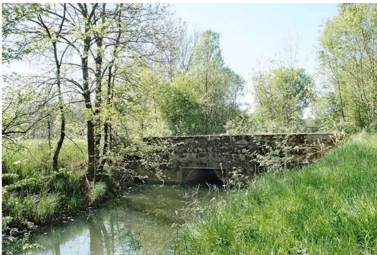
Pont ancien modifié.
