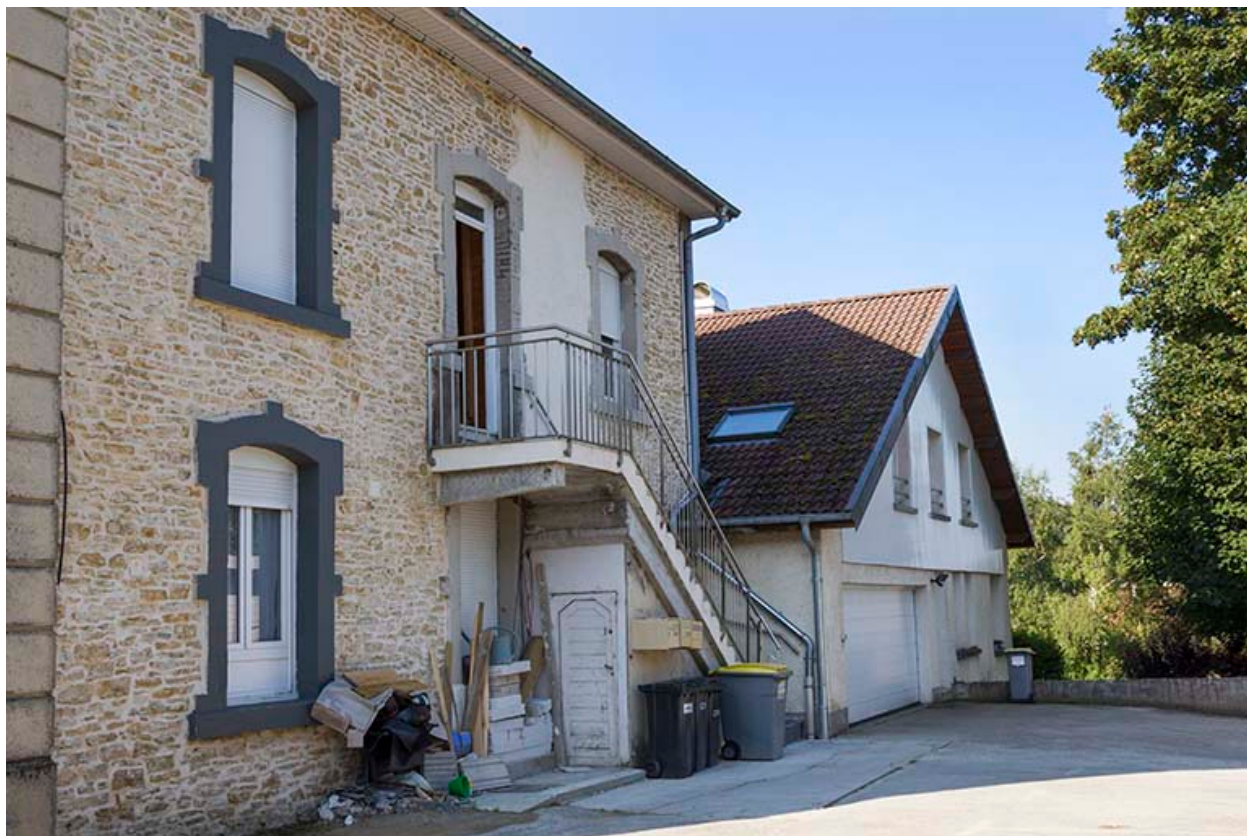
Logement : façade latérale droite.
