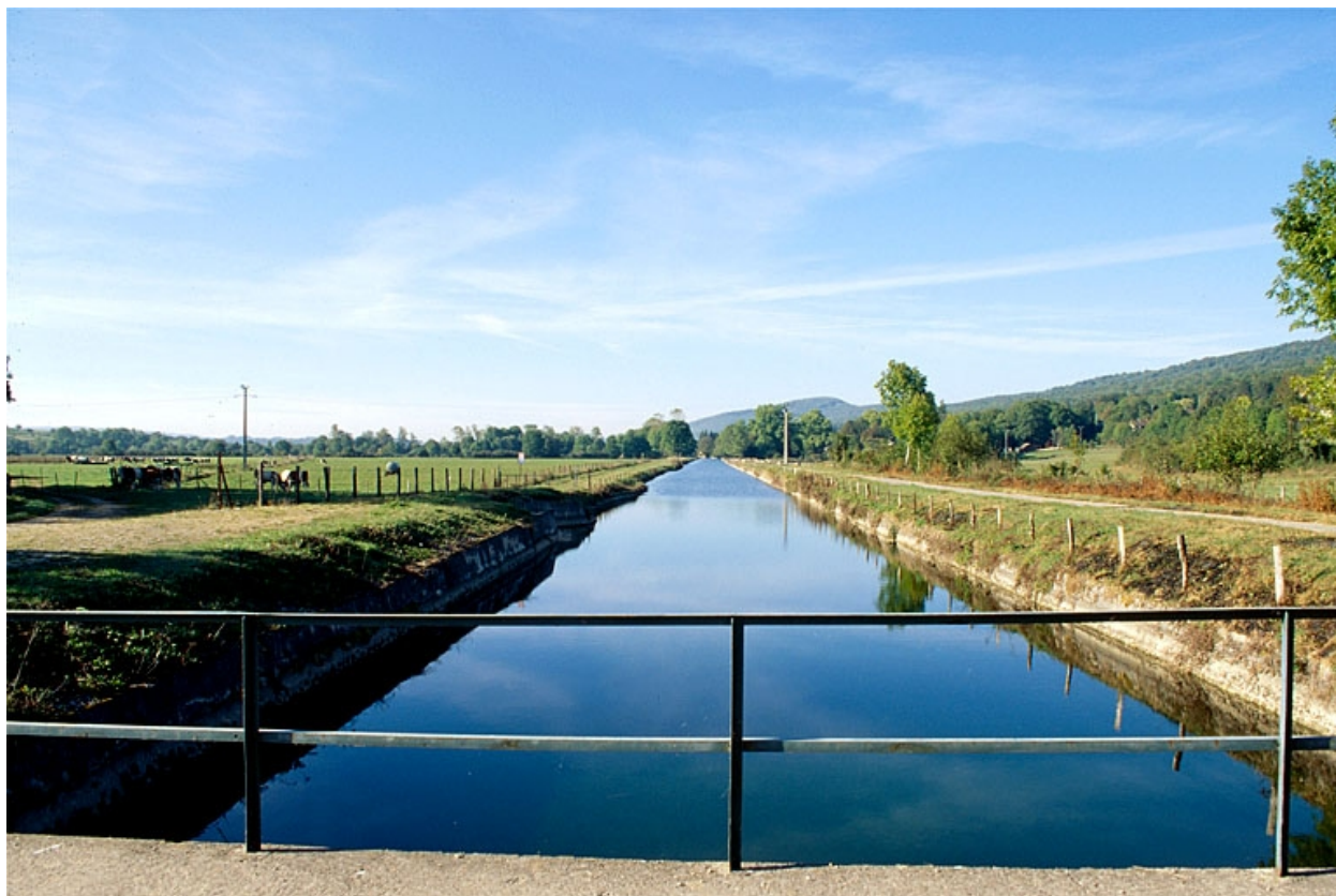
Le canal d'amenée depuis la prise d'eau.
