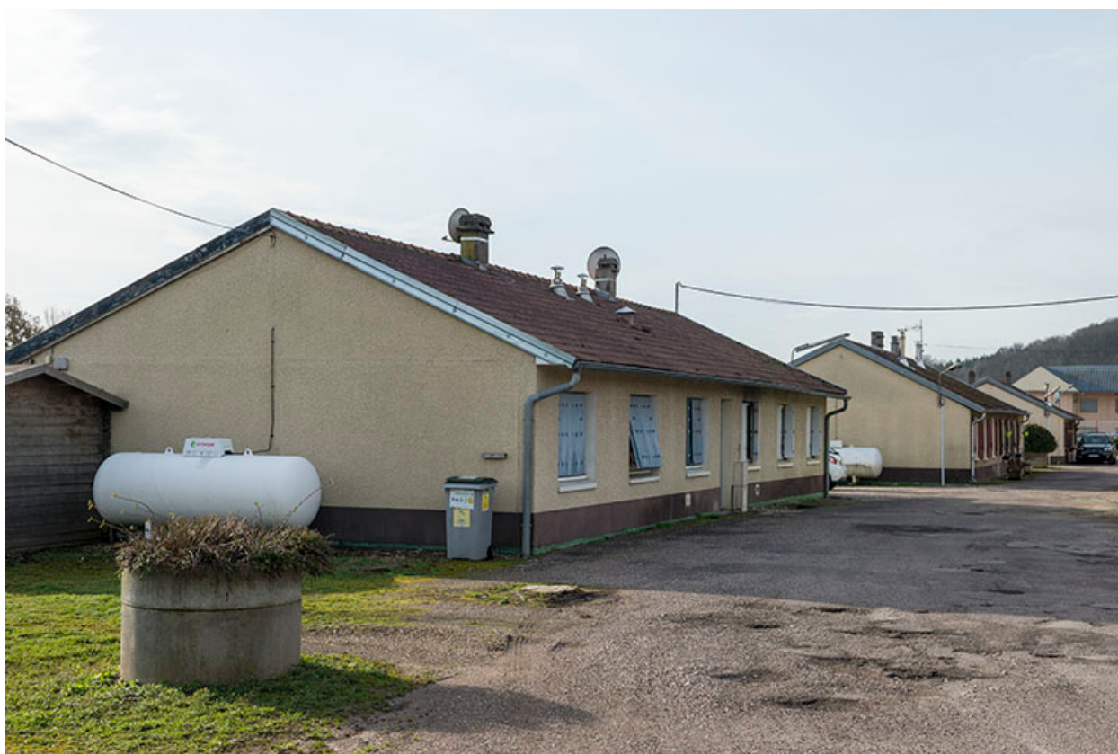
Bâtiment servant de cantine et logement.
