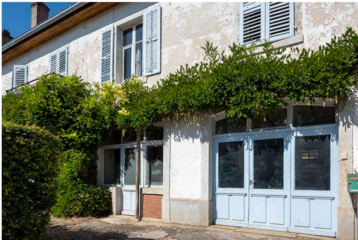
Bâtiment au 8 Grande Rue : portes du magasin.
