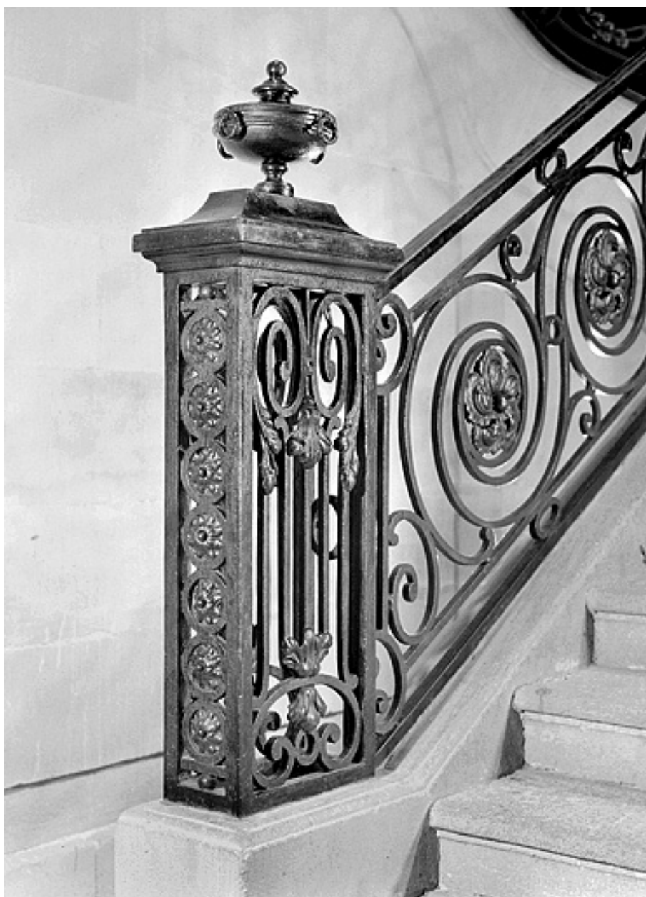
Détail, départ de la rampe gauche.
