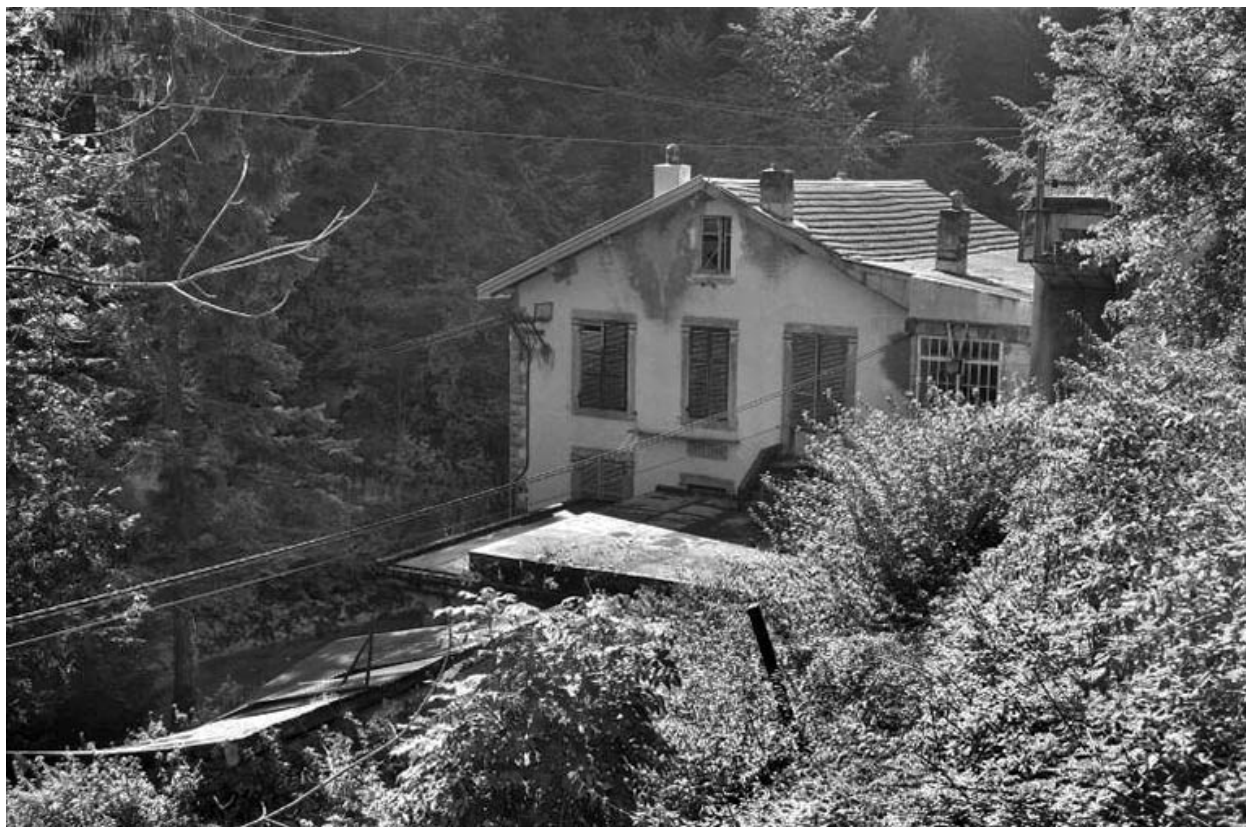
Façade antérieure, vue en plongée.
