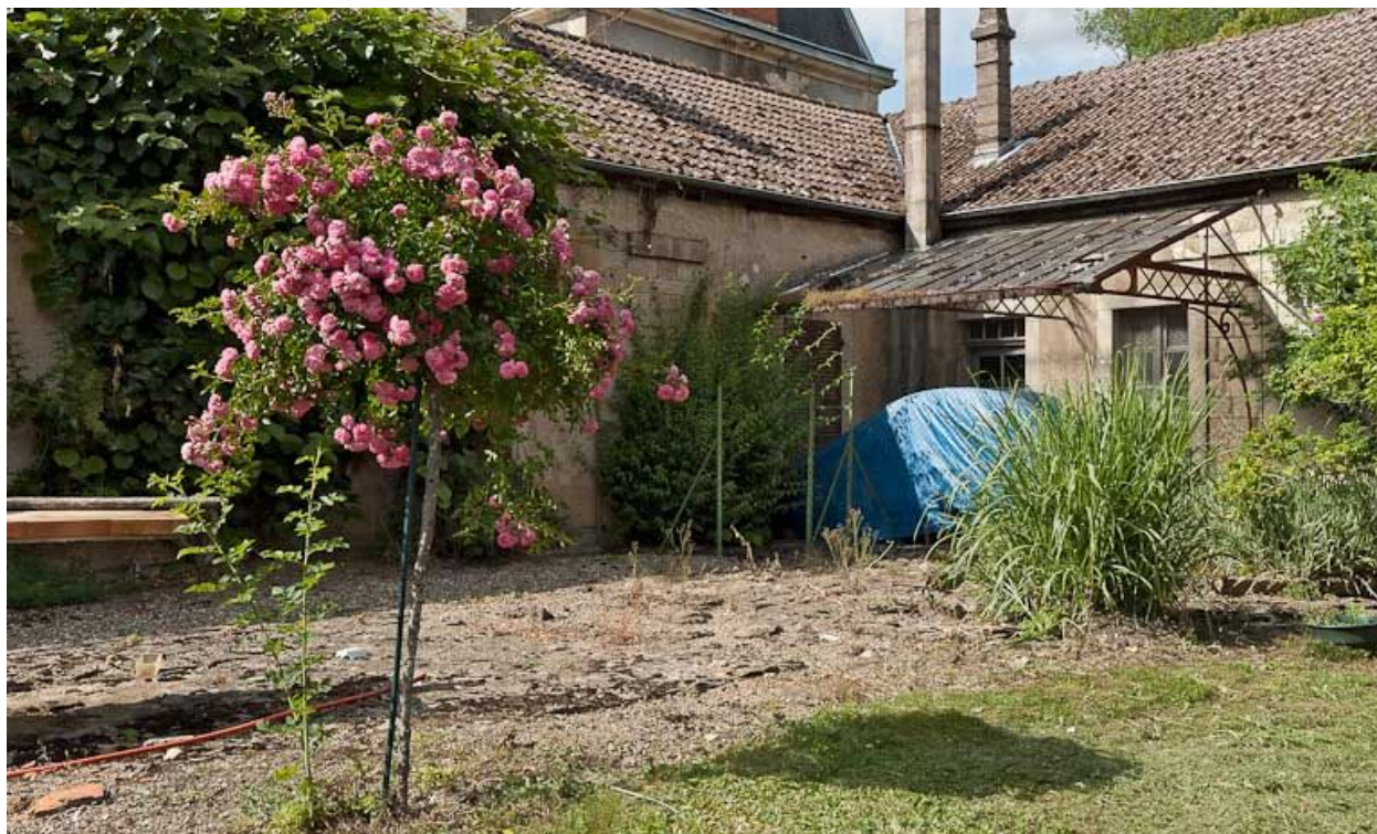
Détail d'une partie de la cour intérieure.
