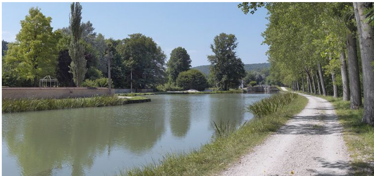
Le port vu d'aval.
