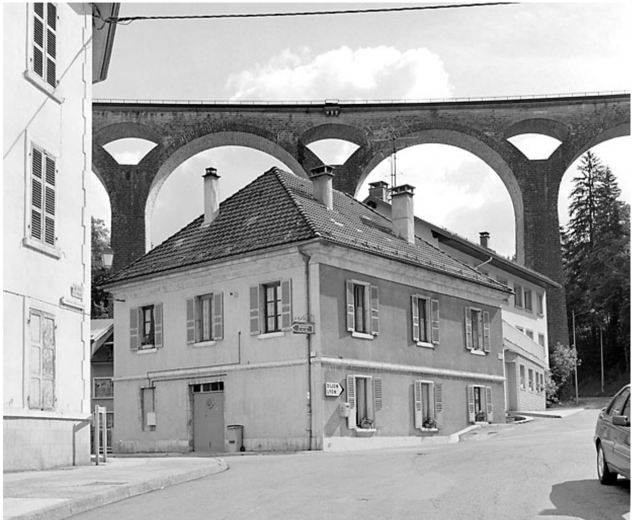
Façades antérieure et latérale gauche.
