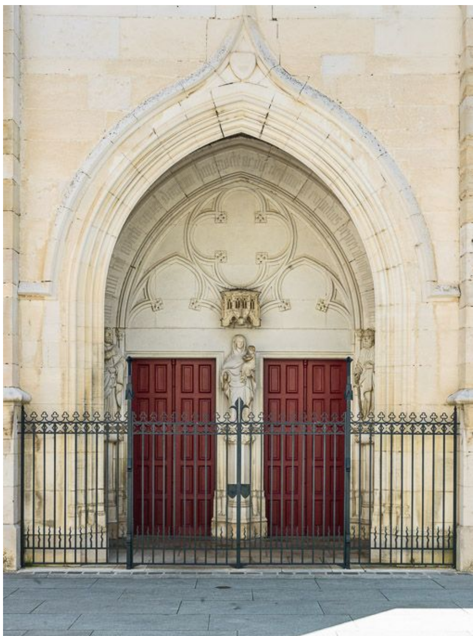
Le portail et les grilles.
