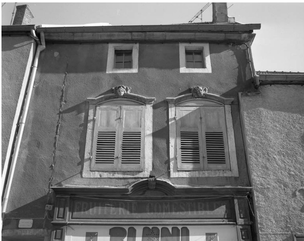
Façade antérieure : détail de la partie supérieure.
