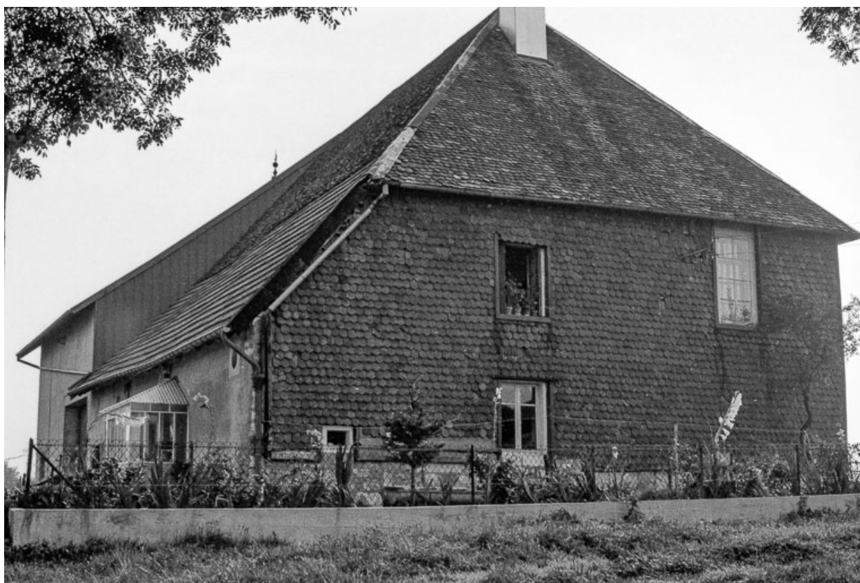
Ferme : façades antérieure et latérale droite.
