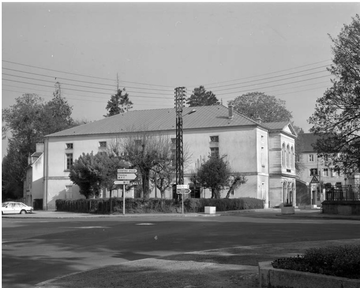
Façades antérieure et latérale gauche.
