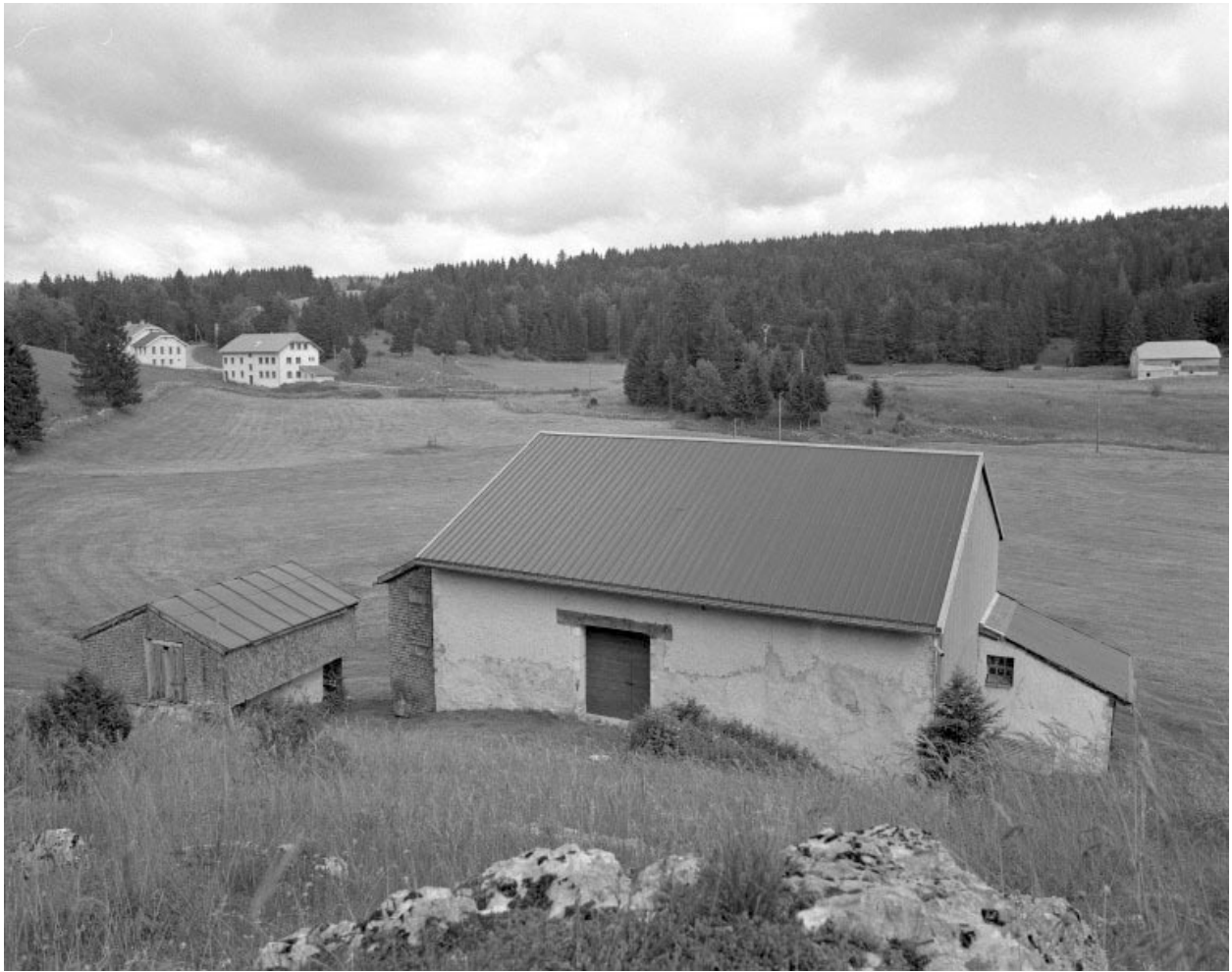
Façade postérieure avec resserre sur la gauche.
