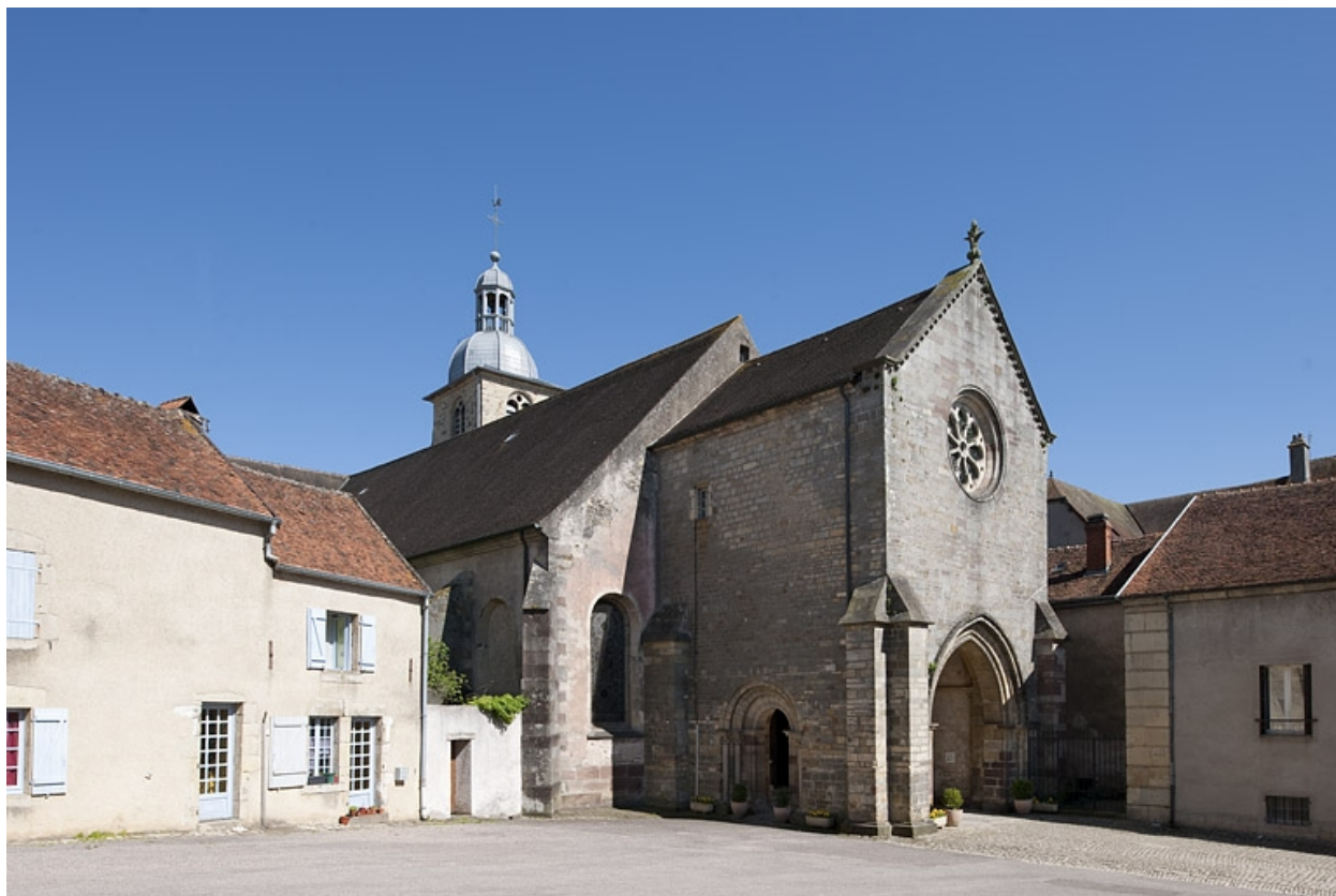
Vue générale depuis la place Sainte-Gude.
