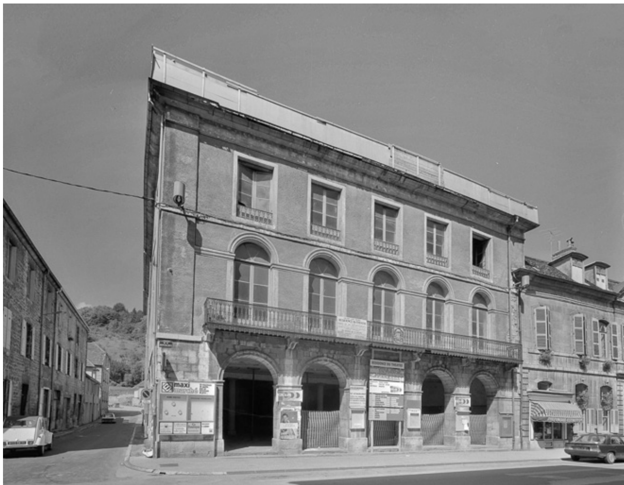
Vue de la façade est avant déconstruction (1987).
