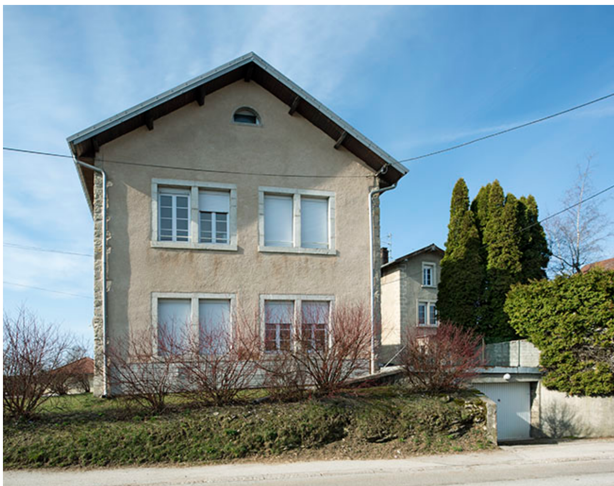
Atelier de fabrication : façade nord.
