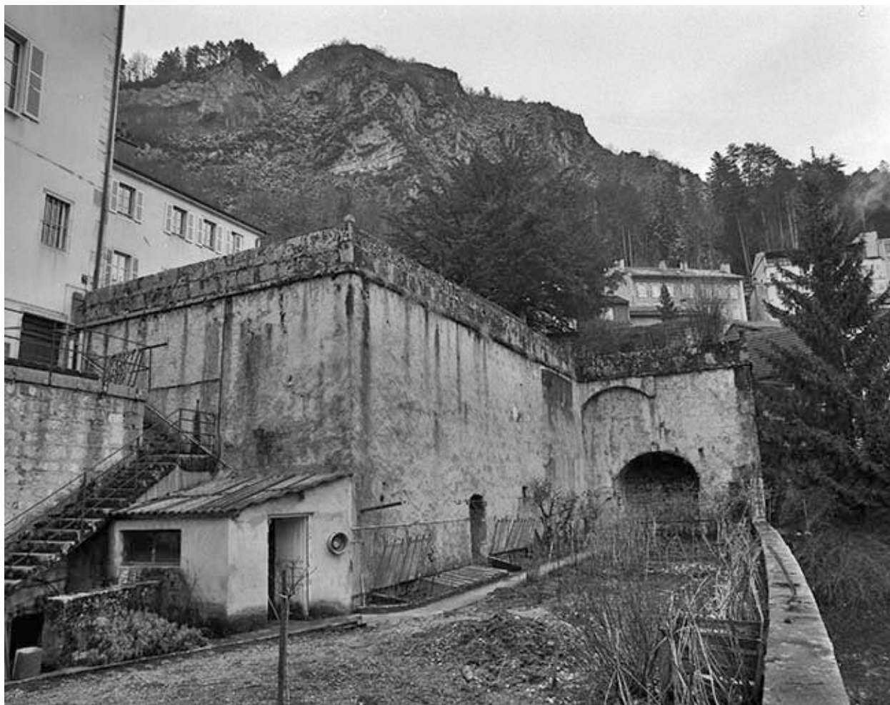
Mur de soubassement du jardin.
