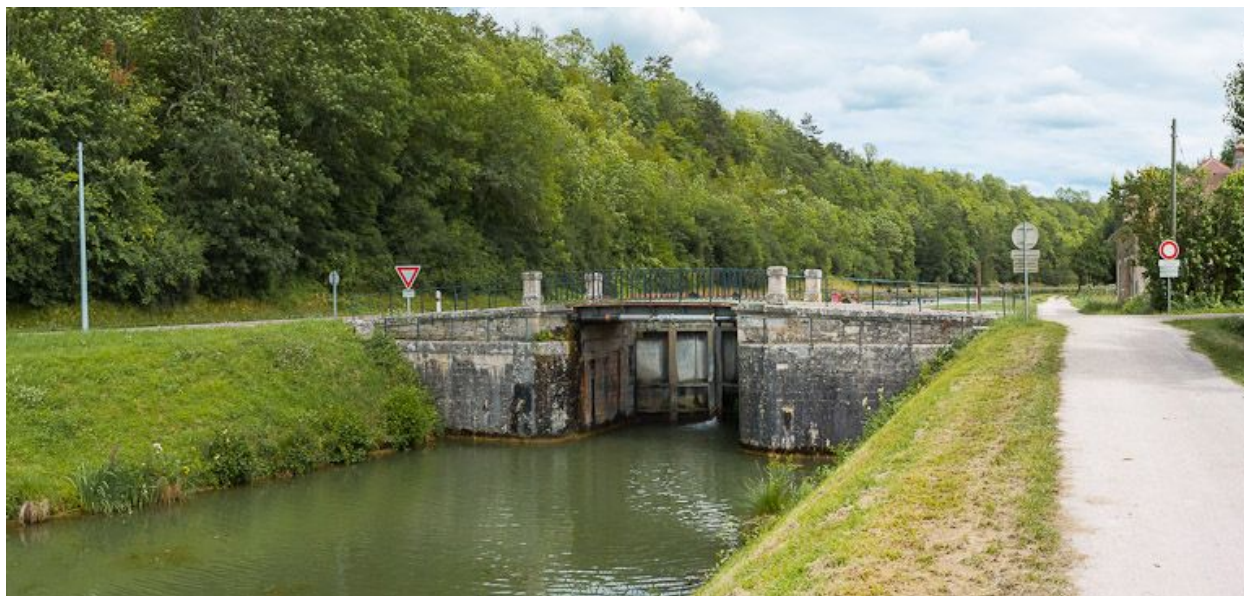
Vue d'ensemble, d'aval.
