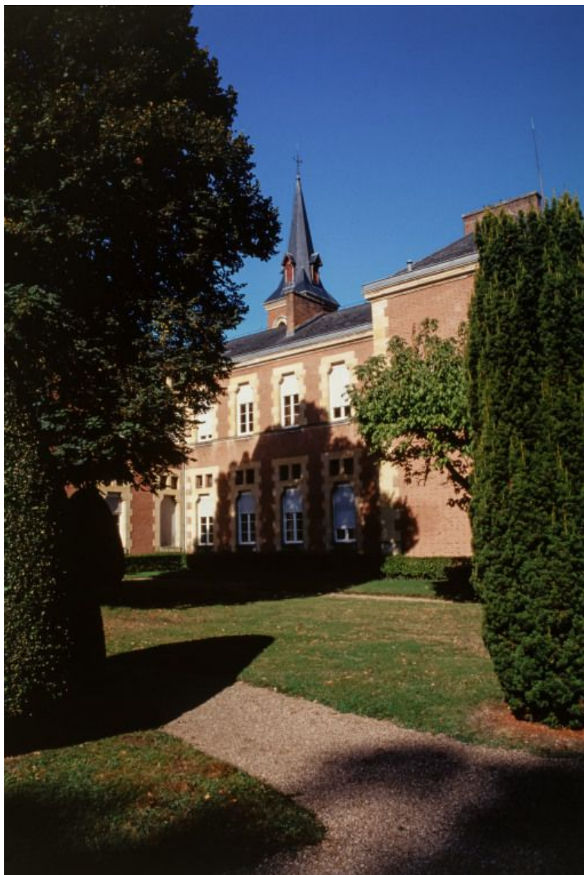
Aile gauche, façade postérieure.
