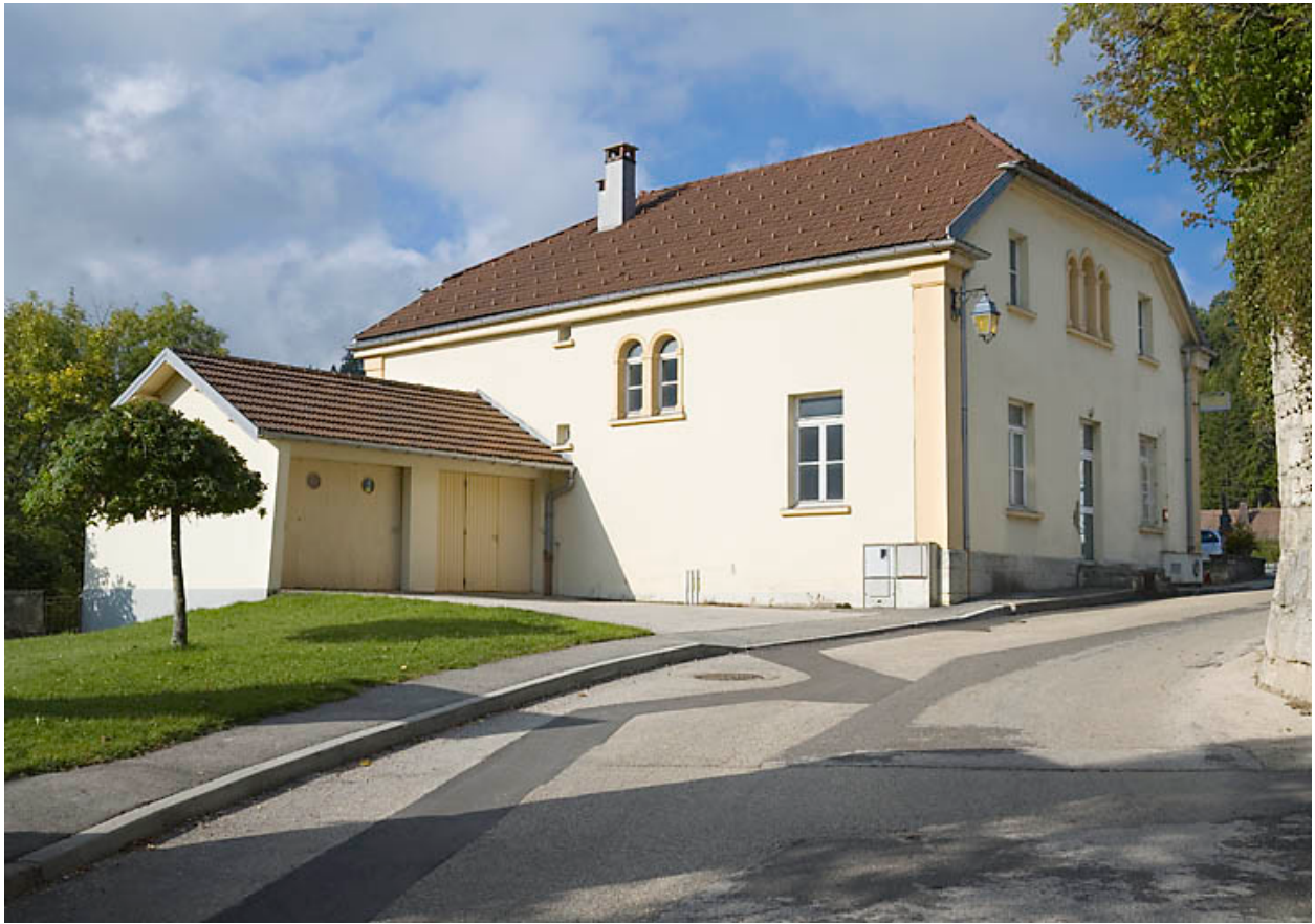
Façade postérieure et façade latérale gauche.
