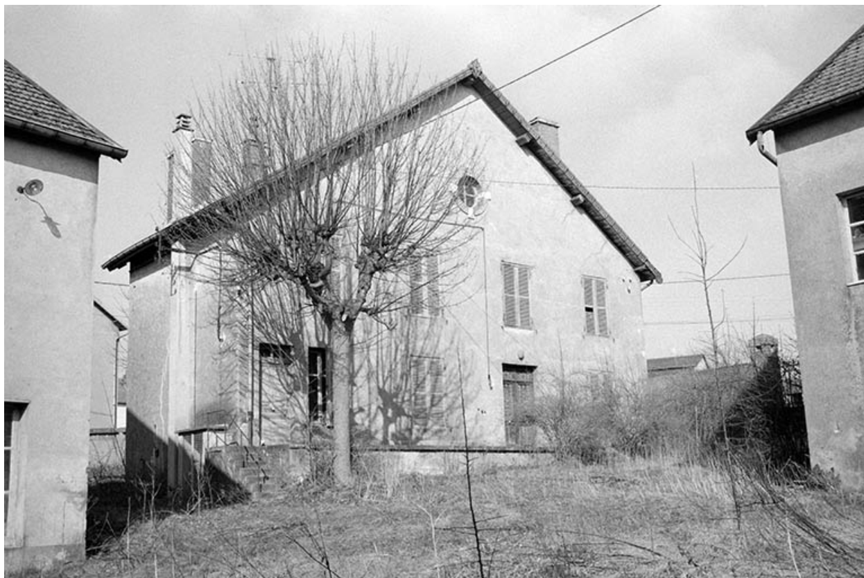
Façade antérieure du bureau vue de l'est.
