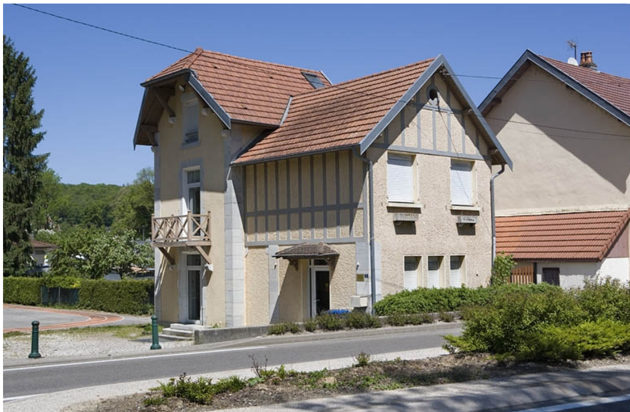
Conciergerie du logement patronal. Façade sur cour.
