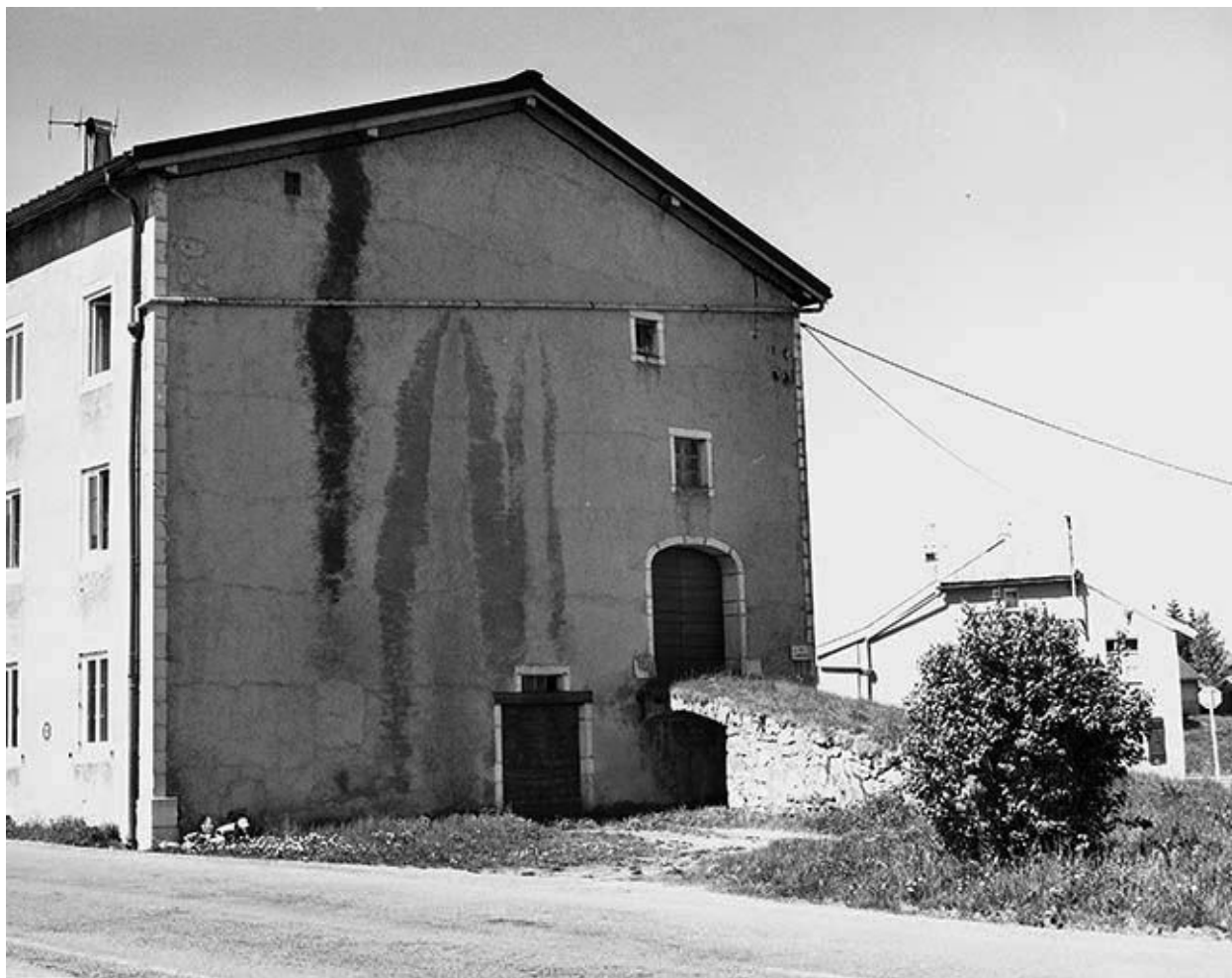
Façade postérieure et pont de grange.
