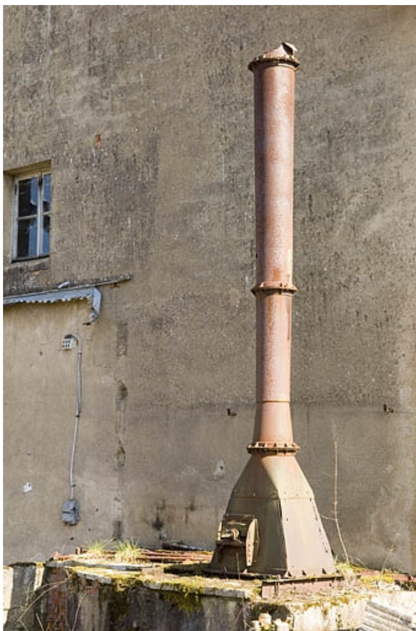
Vestige de la cheminée métallique.
