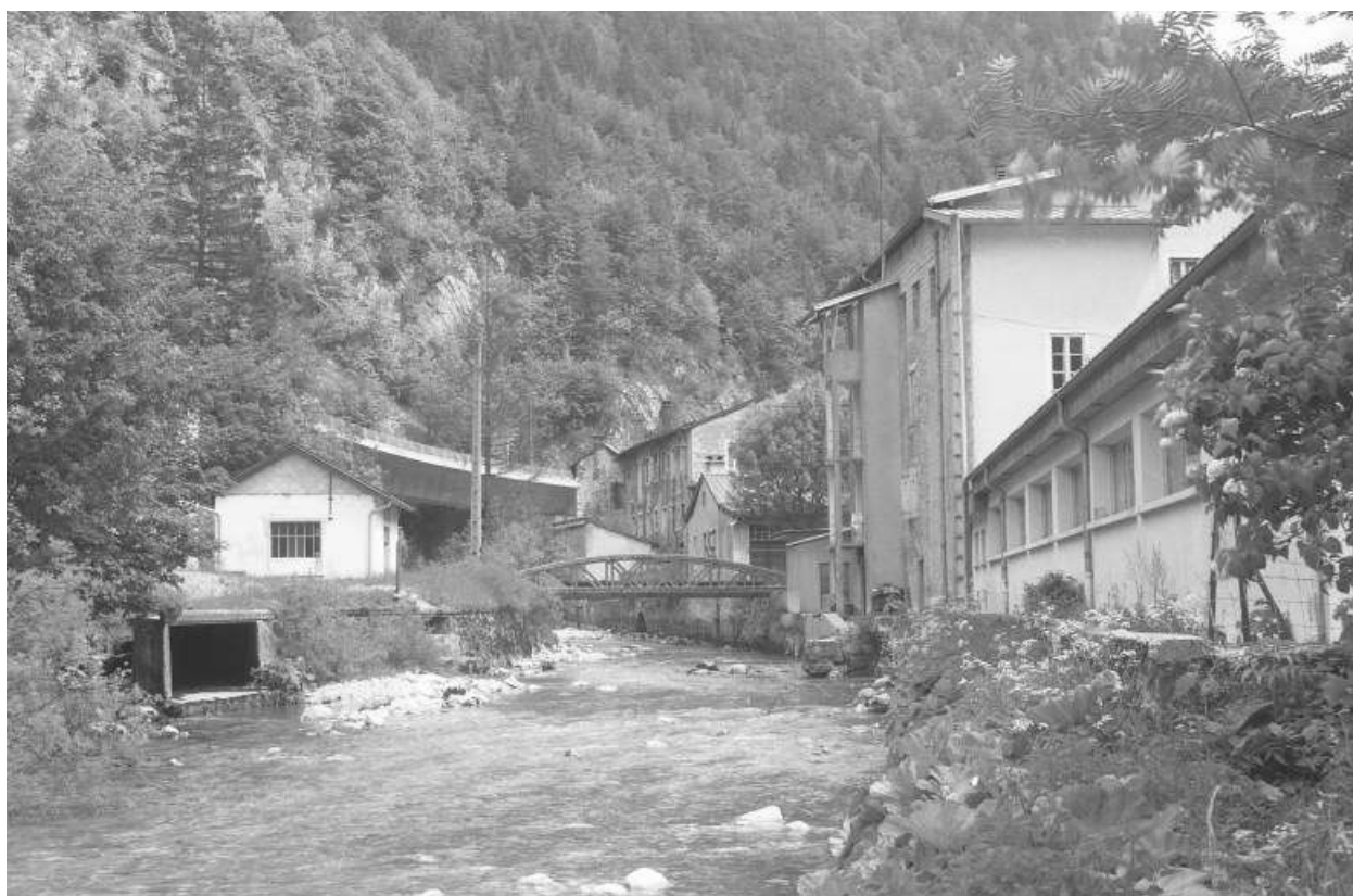
Vue d'ensemble depuis le nord-ouest (aval).
