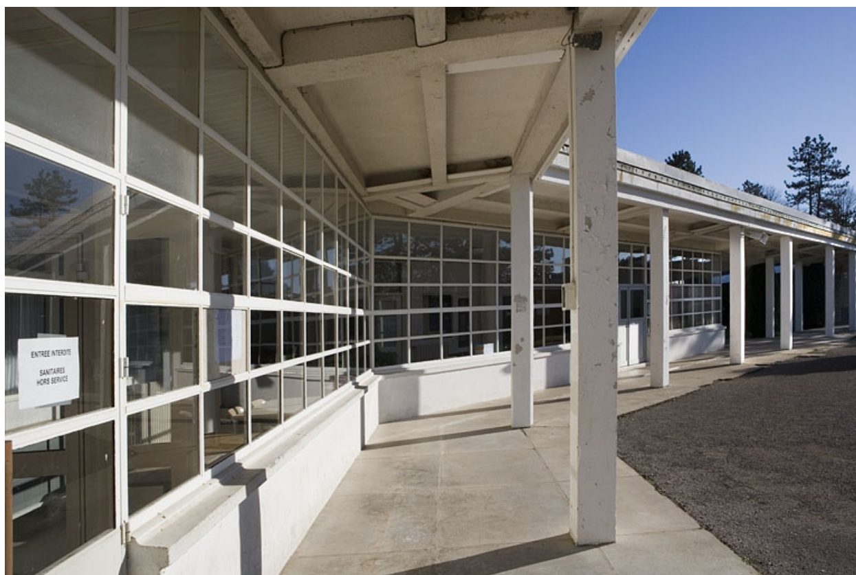
Façade de l'externat : détail
