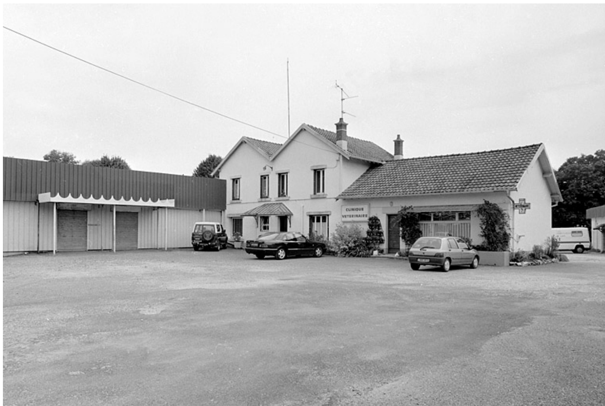
Façade des bureaux (?).
