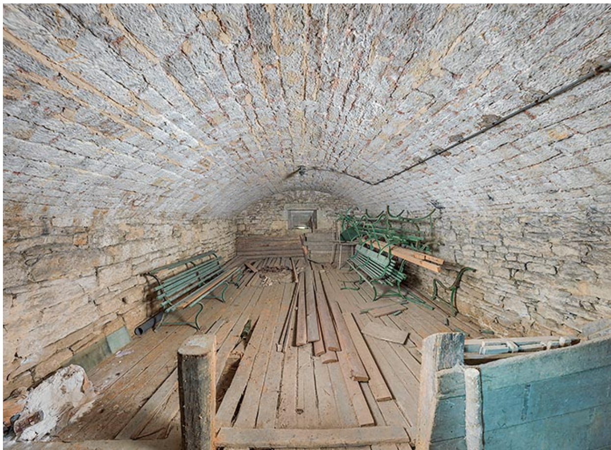
Casemate et sa voûte à l'épreuve.
