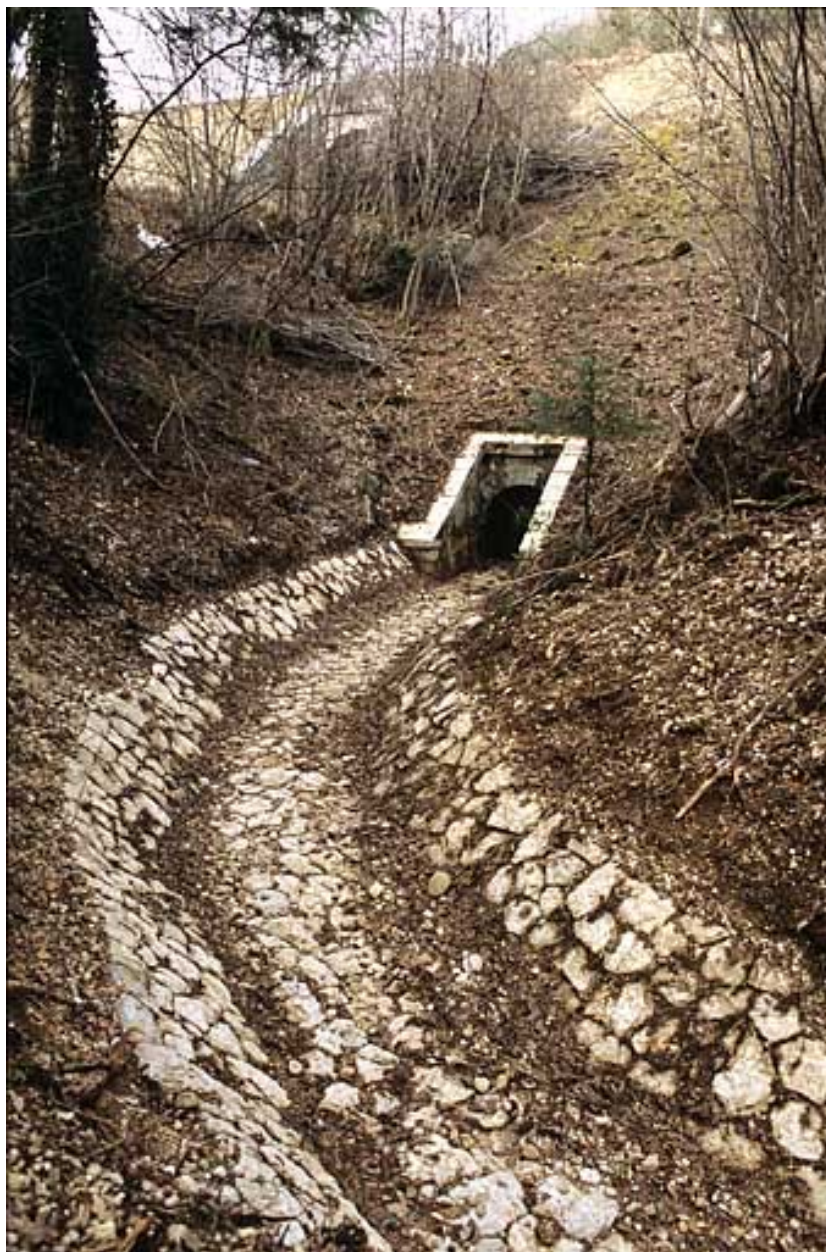
Aqueduc : tête aval (ouest) et rigole.
