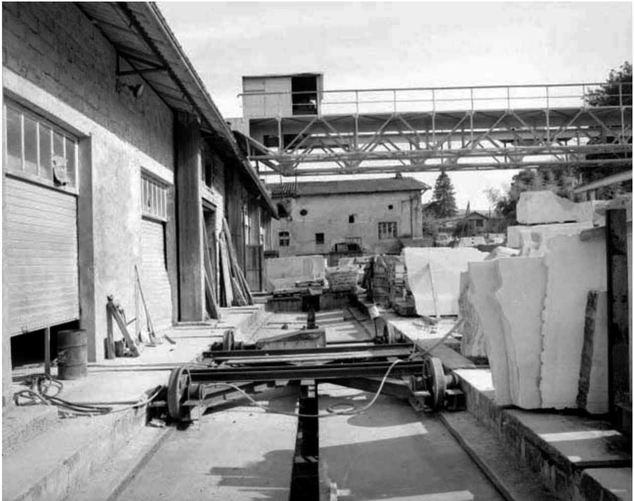
Chariot desservant l'atelier de fabrication.
