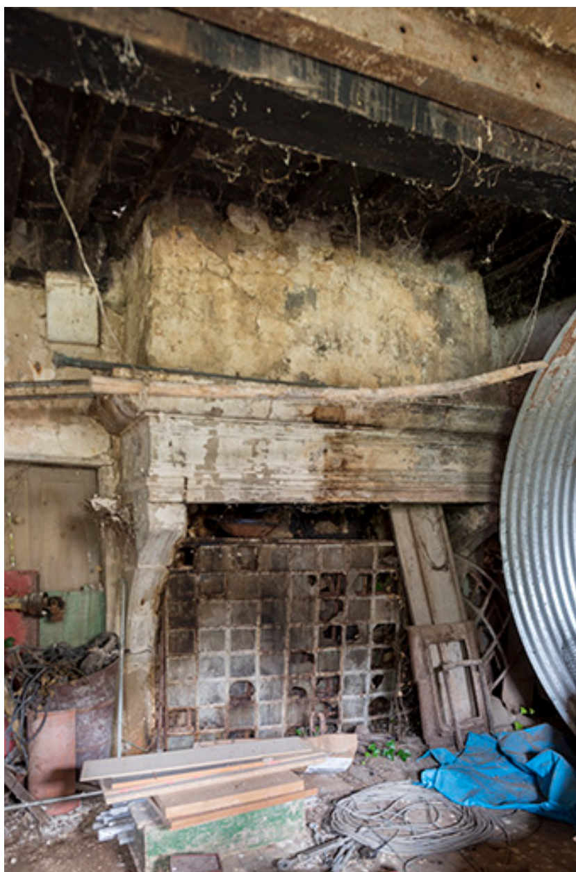
Cheminée adossée, au rez-de-chaussée de l'ancien logis.
