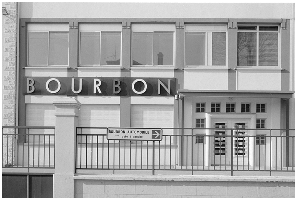
Entrée des bureaux.
