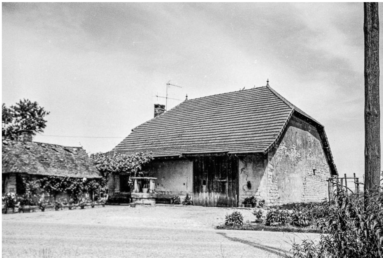
Ferme cadastrée 1963 AC : vue générale.
