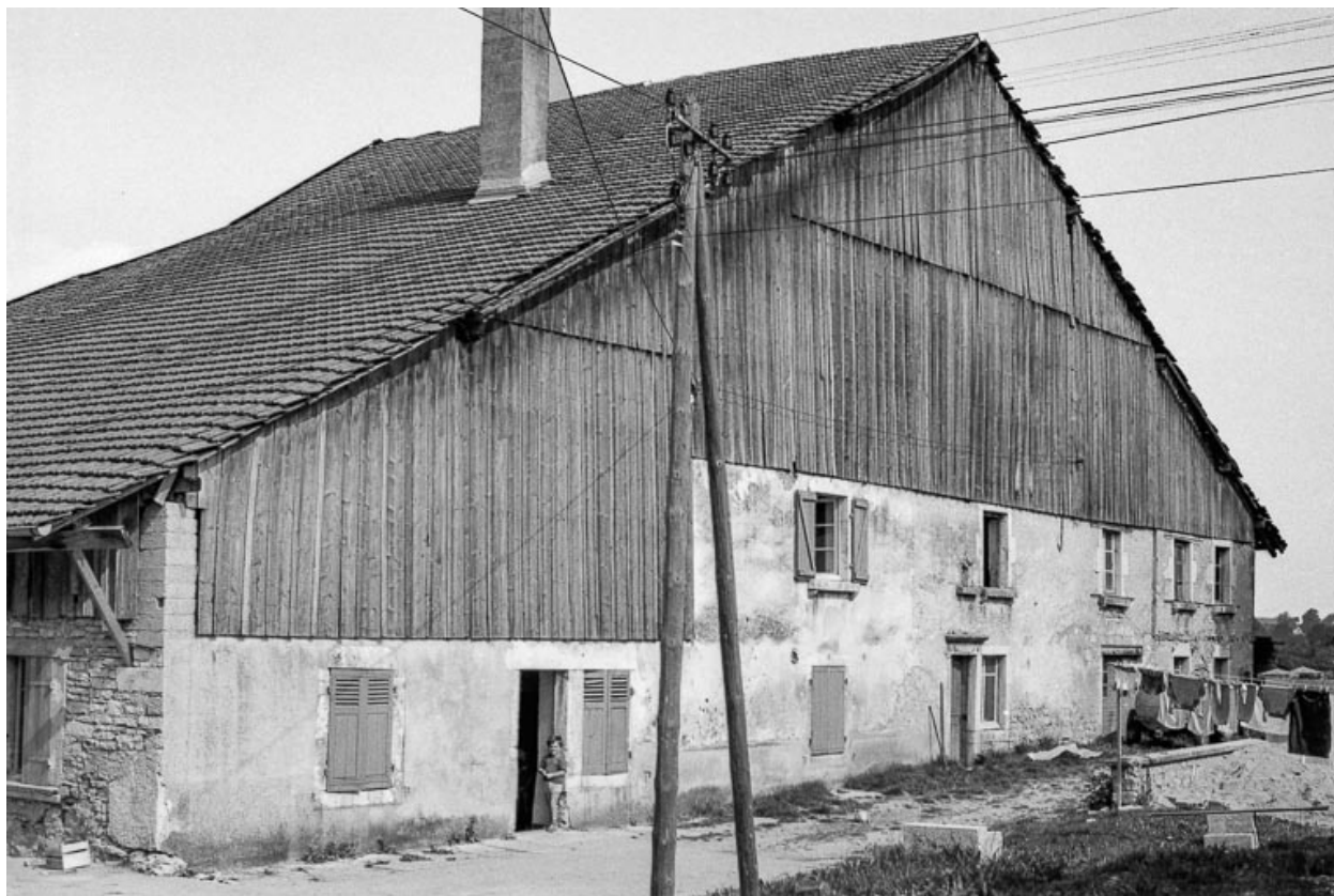
Ferme cadastrée 1964 D 131-133 : façade antérieure.
