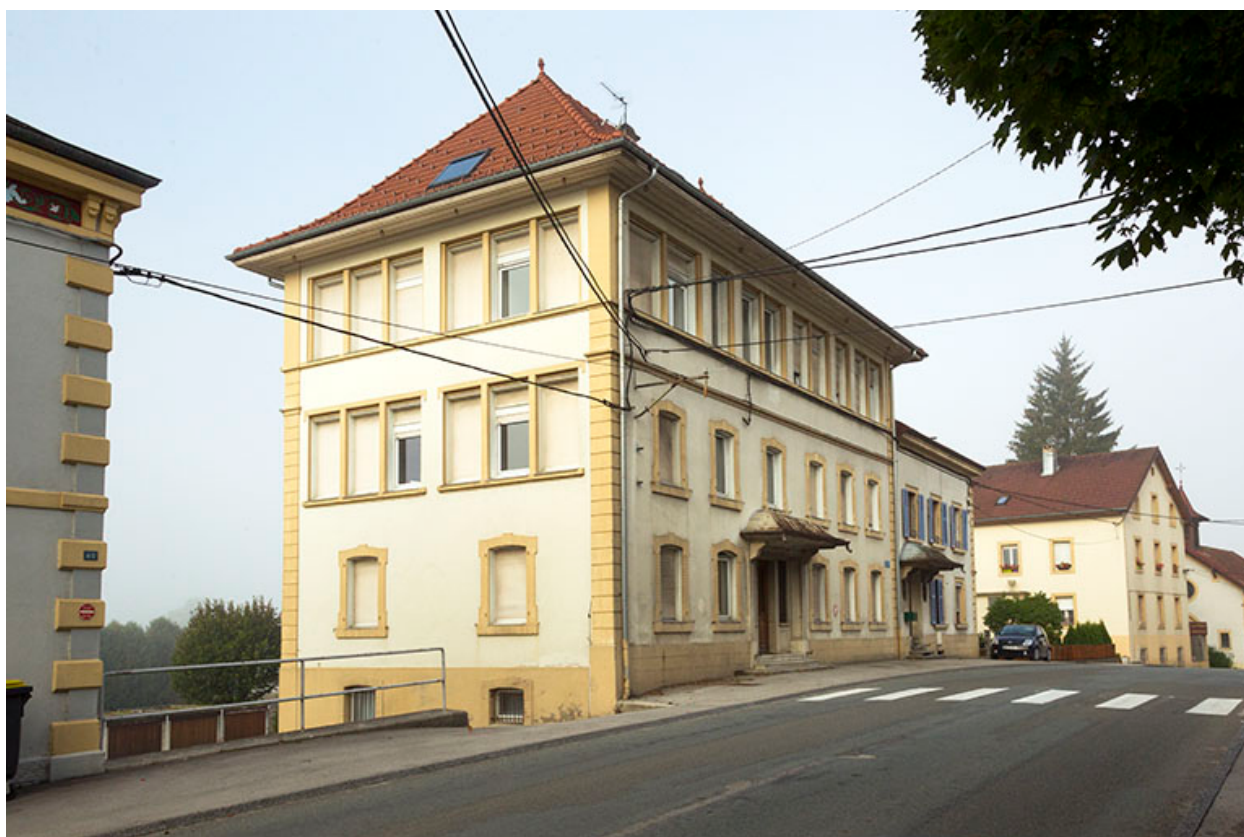
Vue d'ensemble depuis l'est (façade antérieure).
