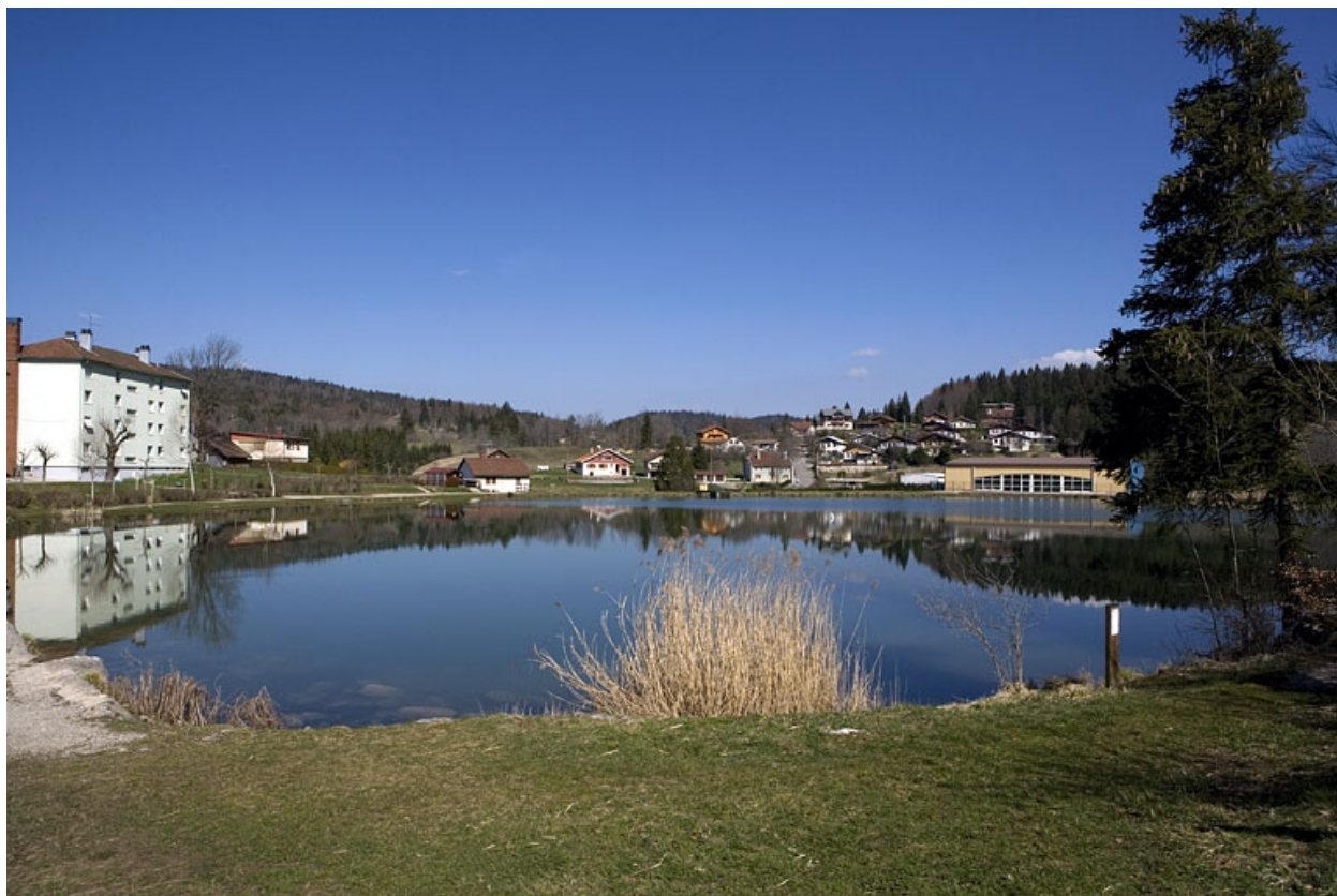
Réservoir : vue d'ensemble, depuis le sud.
