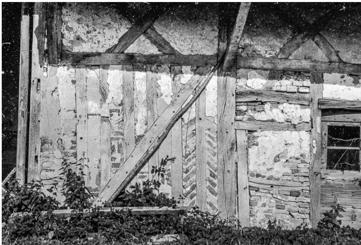
Ferme cadastrée 1956 A1 142-143 : détail du mur.
