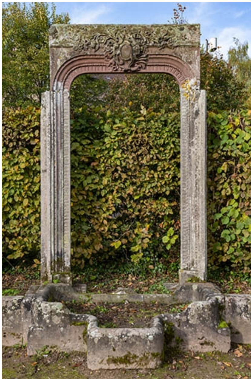
Encadrement de porte, vue de face.
